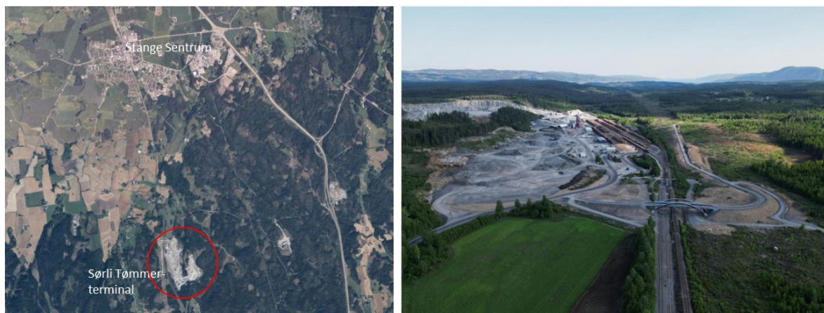
Figur 36 Til venstre foto over Stange sentrum i nord og Sørli-terminalen i sør. Kilde: norgebilder.no. Til høyre dronebilde av Sørli terminal. Kilde: Stange kommune
