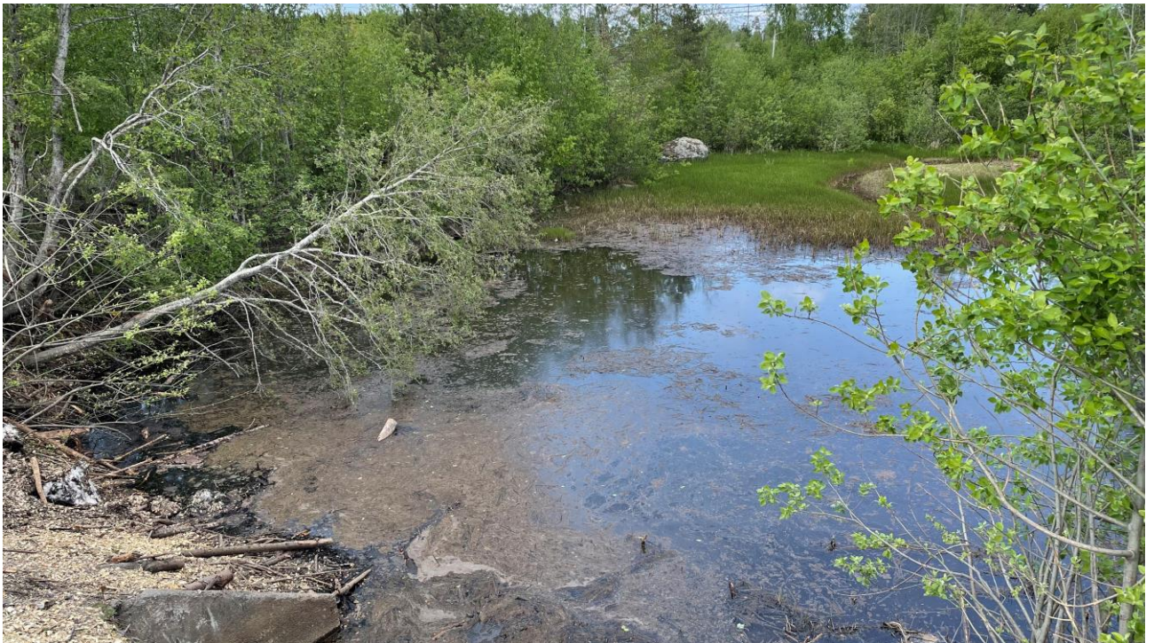
Figur 39 Sørli dam 1. Starten på Måsåbekken
