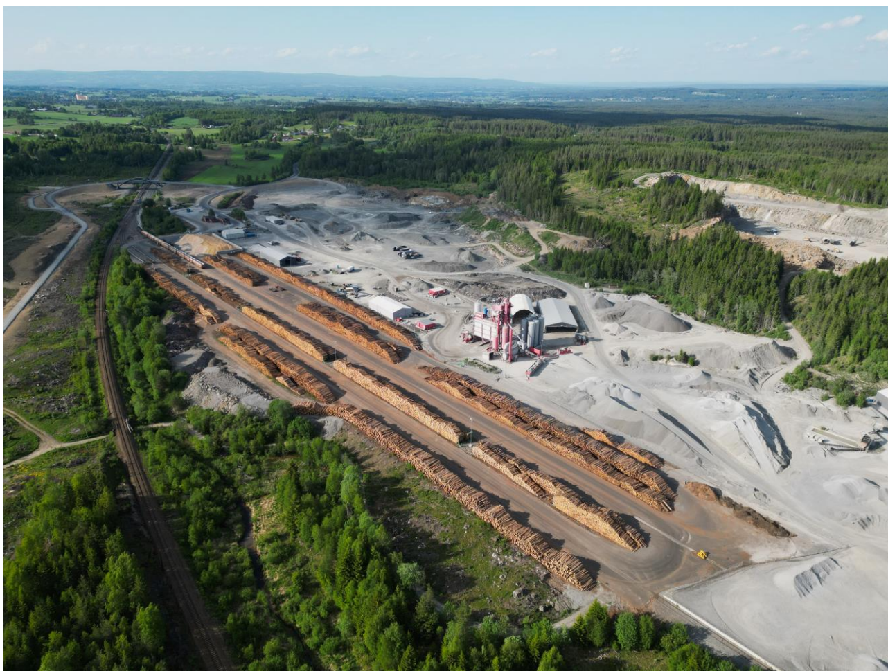
Luftfoto av Sørli tømmerterminal sett fra sør-vest. Kilde: Stange kommune
